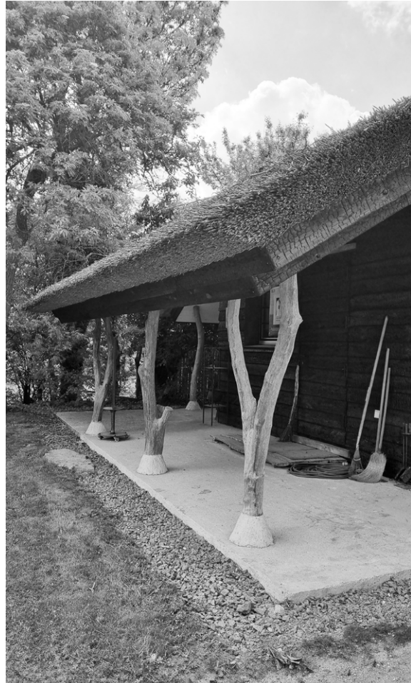
Abbildung 3: Storchenhaus Raiding, Rückseite mit Stützpfeilern
